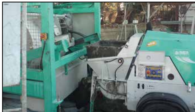
Alimentación mediante central de hormigonado a radio rascante.
