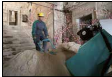
Esscráper/mulilla "opcional", de tracción hidráulica, para facilitar la carga de los materiales sobre la tolva/skip, reduciéndose el esfuerzo personal, y agilizándose el ciclo de trabajo.
