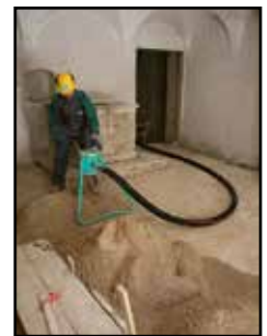
Caballote/trípode para recepción y reparto demorteros y áridos en planta. Se suministra siempre de serie.
