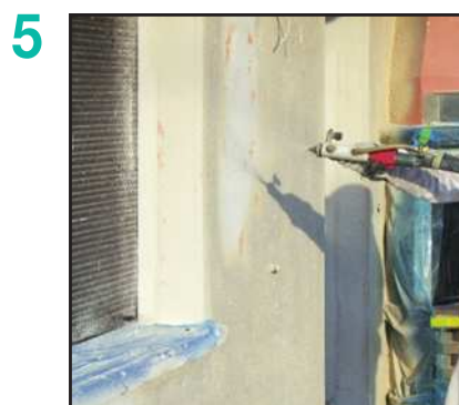
Aplicación proyección del acrílico final
