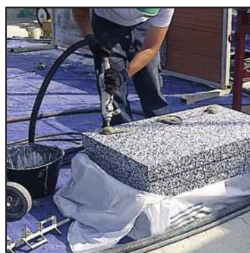
Aplicación del cordón sobre el panel "EPS" termoaislante
