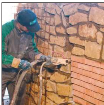
Realizar relleno de juntas
