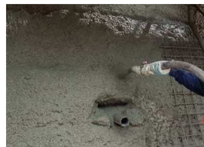
Para enfoscar morteros tradicionales premezclados y monocapas.
