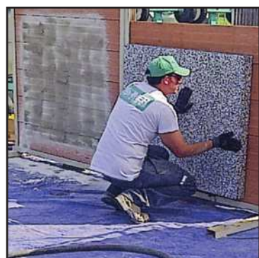
Colocación del panel "EPS" termoaislante
