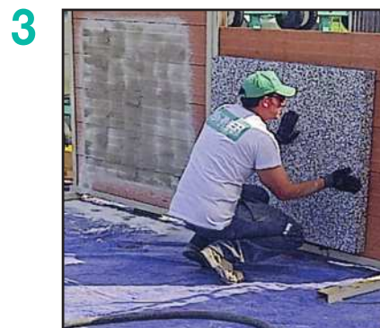
Colocación del panel "EPS" termoaislante
